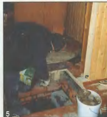
5 Наружную часть основания (по периметру) можно выложить из целых обожженных красных кирпичей, а середину — из половинок.
