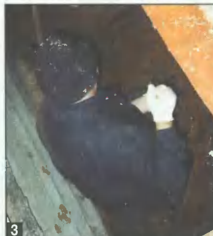
3 Почва под будущей печью оказалась глинистая, поэтому рыть котлован под фундамент пришлось на глубину три штыка лопаты (около 75 см).
