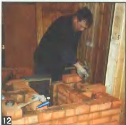
12 При кладке кирпич смачивают водой для лучшего сцепления с глиняным раствором. Толщина шва кладки должна быть 3–5 мм. Положение каждого кирпича проверяют строительным уровнем, подстукивая при необходимости кирочкой. Излишки раствора снимают мастерком.
