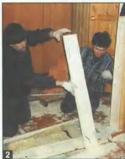
2 Правильно построенный дом обычно имеет двойные полы: чистые верхние и черные нижние, между которыми проложен утеплитель. (Момент разборки пола).
