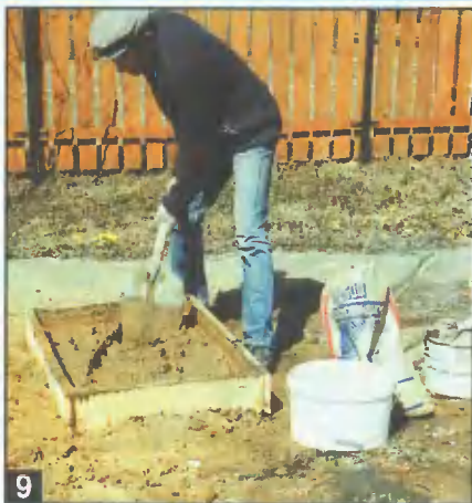
9 Для получения кладочного раствора просеянный песок и глину смешивают в определенной пропорции (в зависимости от жирности глины) и добавляют воду до состояния «густой сметаны».
