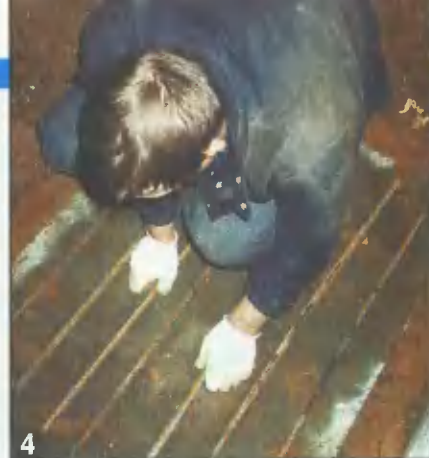
4 Фундамент заливали послойно, с прокладыванием прутков арматуры через каждые 20 см.
