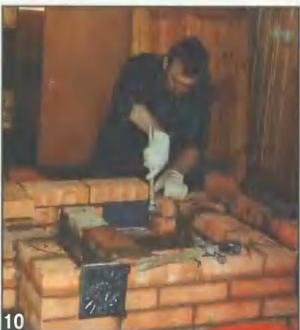
10 Зольная камера, располагаемая под топкой, служит для сбора золы и несгоревших частиц топлива. На фото показан момент перекрытия поддувальной дверцы.
