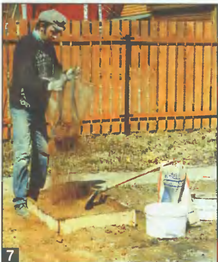
7 Если в песке присутствуют мелкие камни, то его просеивают через сито (сетку) с ячейками 2 мм.
